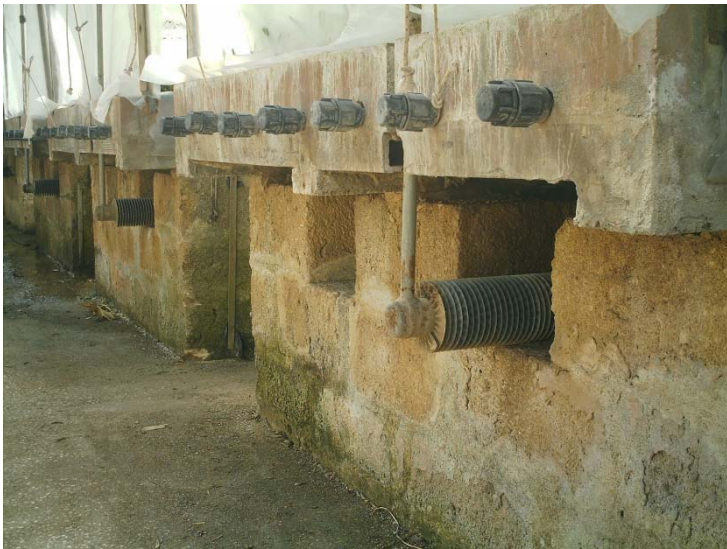
Serra con riscaldamento al bancale
